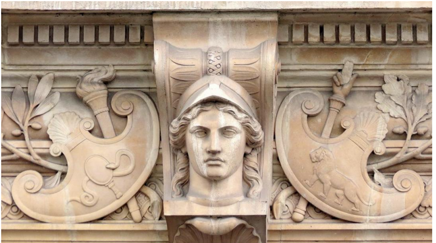
Façade du 5 quai de l'Horloge ©CCASS
